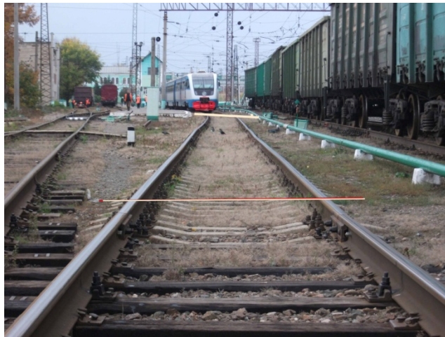
Рис. 9. Пример поля зрения одной из камер стереопары. Красной линией отмечена граница ближней, а жёлтой – дальней зоны анализа изображения пути
