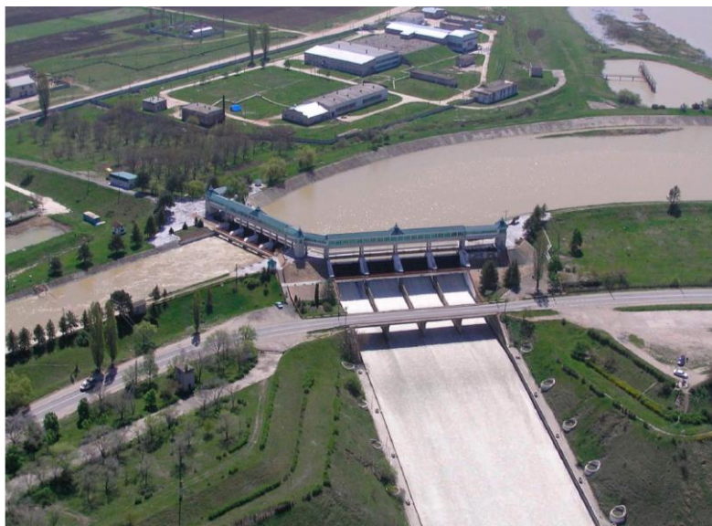
Рис. 2. Усть-Дзегутинский гидротехнический узел
