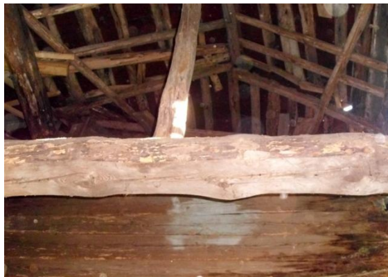
Рис. 1. Общий вид несущей деревянной балки церкви Николая Чудотворца (Брянская область), 1865 г. постройки
